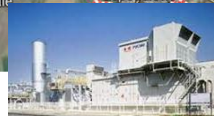
1 turbogas da 20 MW
